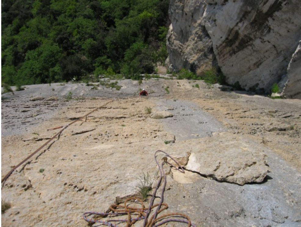
La placconata sotto il tetto
