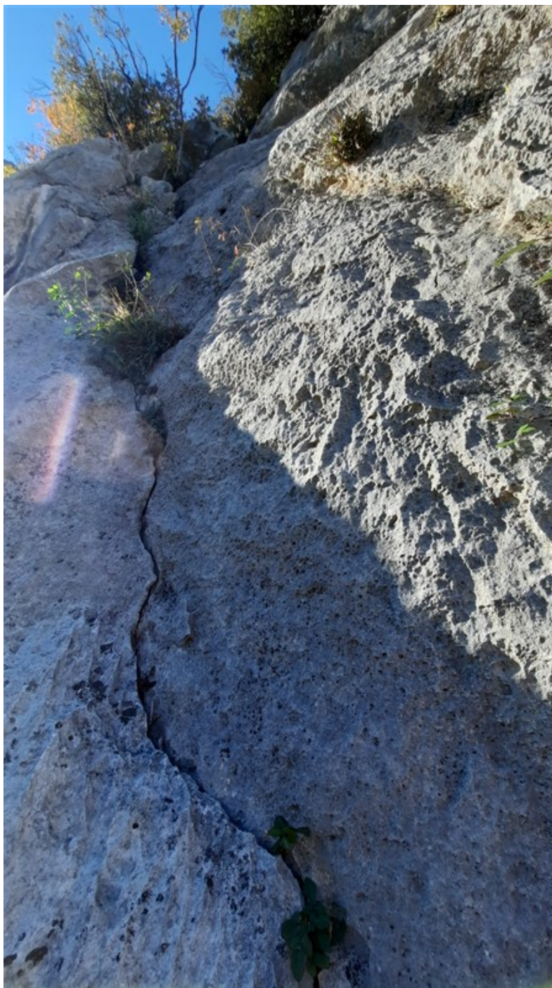
La fessura all'inizio della quarta lunghezza
