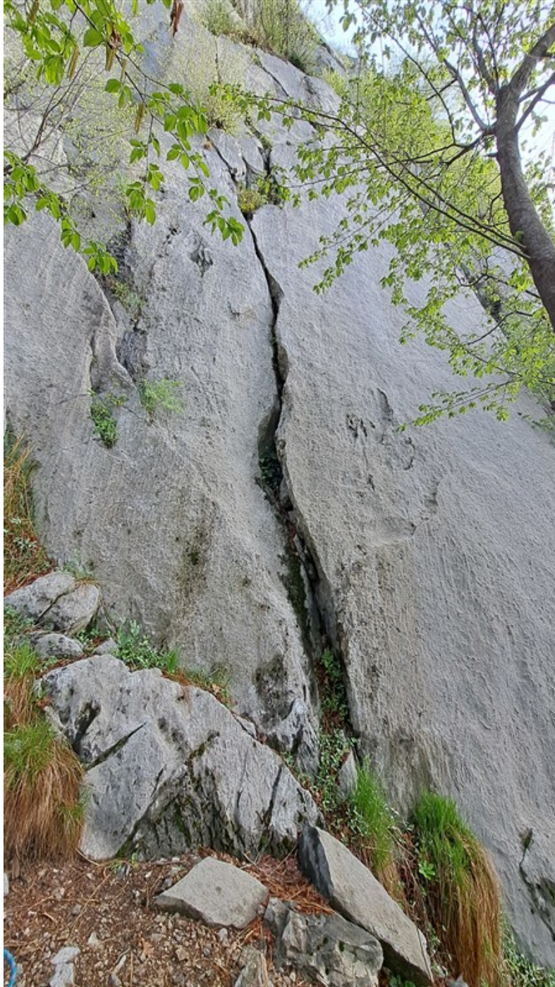
La fessura di attacco
