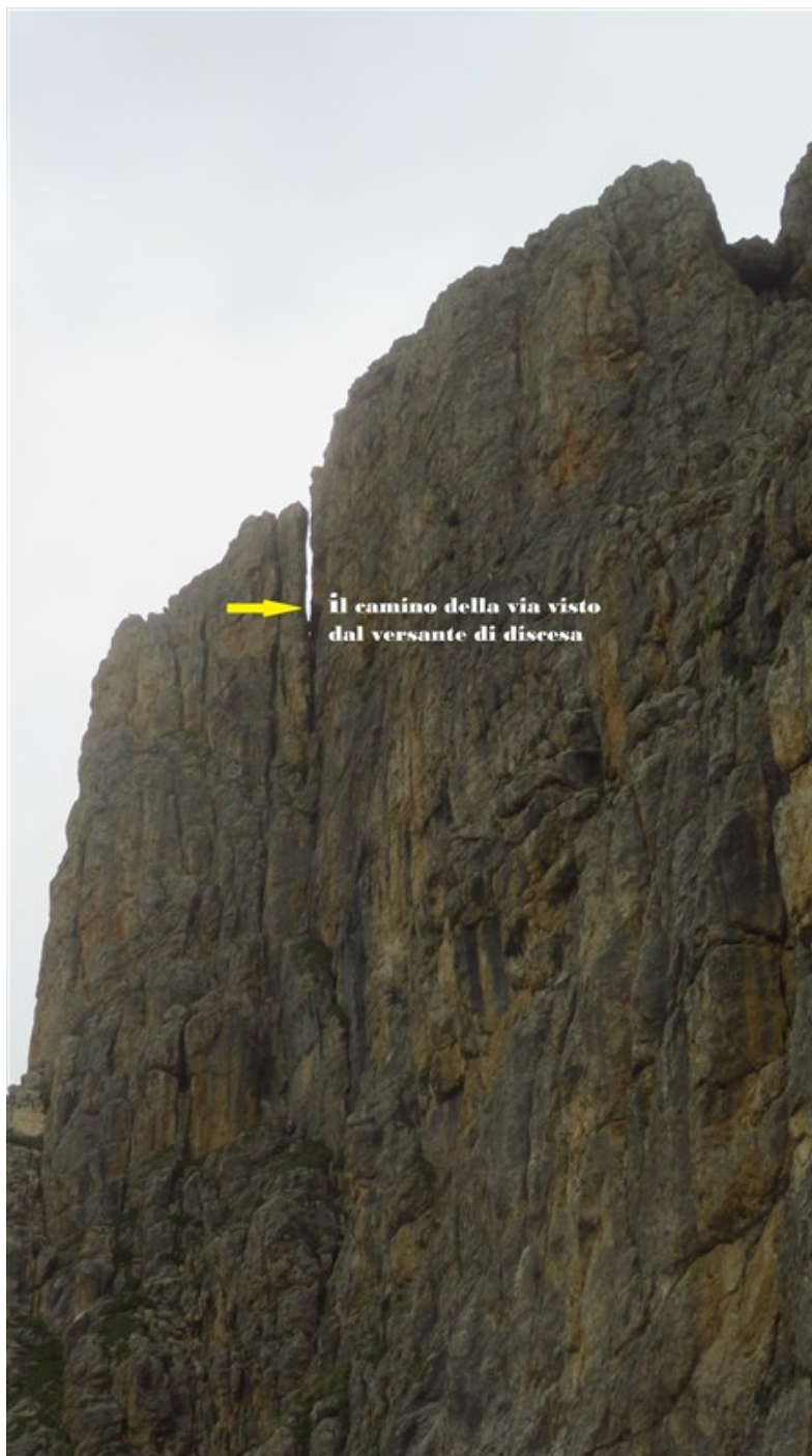
Il grande camino visto dal versante di discesa
